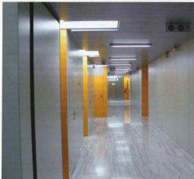
Encima de estas líneas, detalle de la integración de las puertas antincendios. Más arriba, detalle del revestimiento cerámico.
