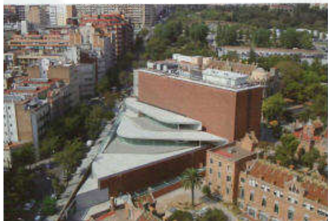
Vista aérea del edificio.
